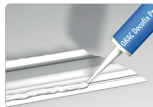
Påfør monteringslim på skinnen og taklisten
